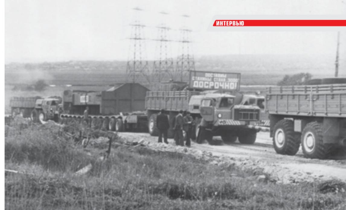
на нем был перевезен 260-тонный трансформатор в городе Сумы – от железнодорожной ветки на подстанцию машиностроительного завода.
